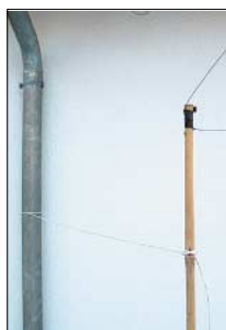
Bild 3: Vier Bambuspflanzstäbe dienen als Stützen an den unteren Ecken der Dreiecke; eine Abspannung, hier am Regen-Fallrohr, ist unbedingt erforderlich.
